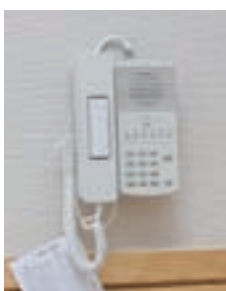
▲各学年の教室に設置されているIP標準マスター端末N-8510MS。警報メッセージの通報や各教室間の連絡にも活用。
