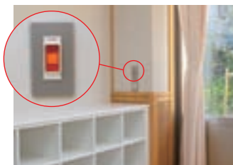
▲教室の前後に設置されている緊急通報ボタン。このボタンを押すと、IP端末、校内放送で緊急通報が可能。
