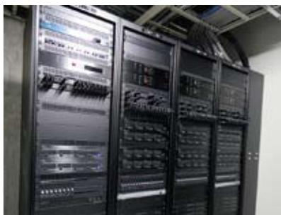
アンプ室は3ヵ所に分散して設置し、スピーカーへの配線距離を短縮している
